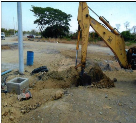
Foto 3.- Retroexcavadora para zanjeado ductos y conductores subterráneos
