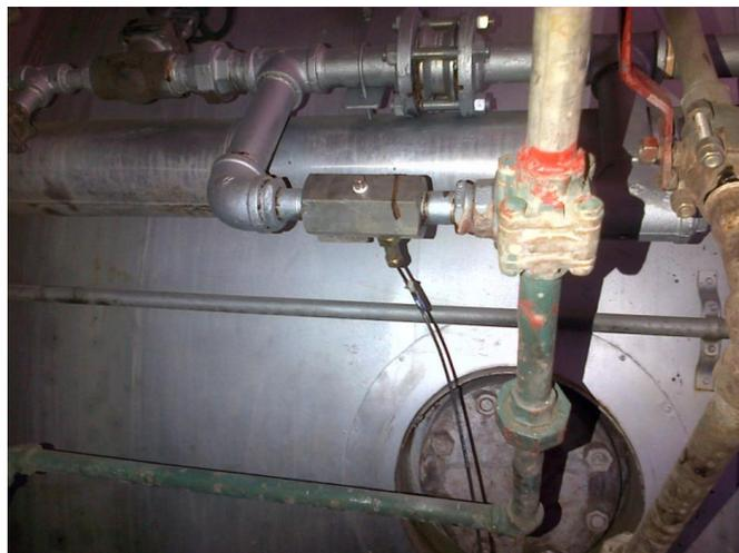
**FIGURA 5.3 UNIDAD DE DETAECCIÓN DE CONDUCTIVIDAD EN LA LÍNEA DE PURGA DE SUPERFICIE, PARTE DEL SISTEMA AUTOMÁTICO DE PURGA DE SUPERFICIE DEL CALDERO.**
