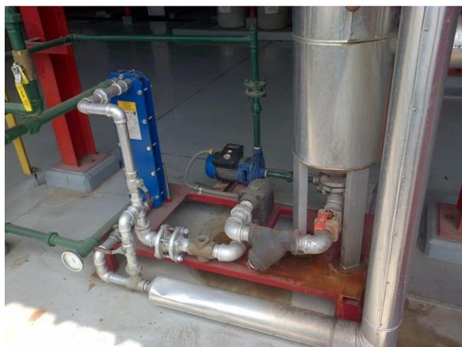
**FIGURA 5.1 SISTEMA DE RECUPERACIÓN DE ENERGÍA DE PURGAS DE CALDERA.**
