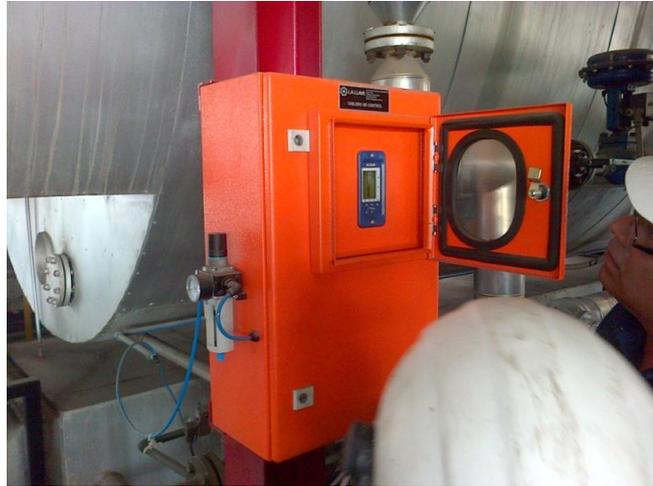
**FIGURA 5.2 TABLERO DEL CONTROLADOR DEL SISTEMA AUTOMÁTICO DE PURGA DE SUPERFICIE DE CALDERO**
