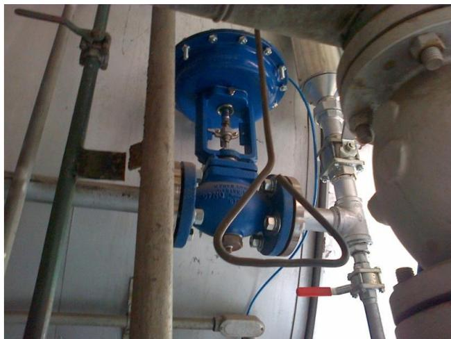
**FIGURA 5.4 VÁLVULA DE CONTROL NEUMÁTICA DEL SISTEMA
