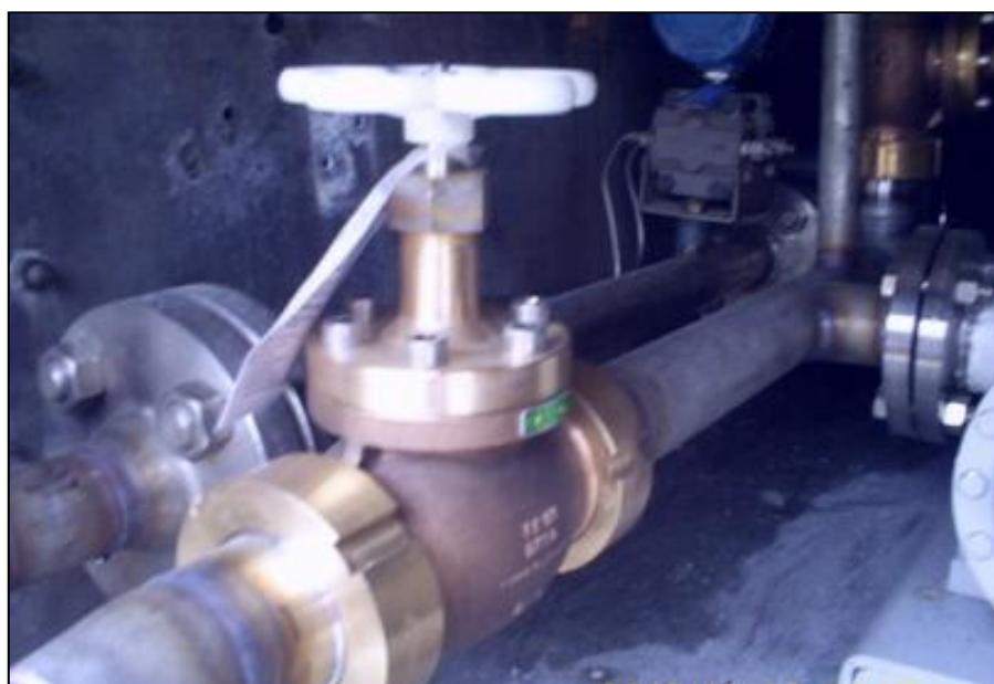
Figura 3.9. Vista de la válvula de globo Herose seleccionada
