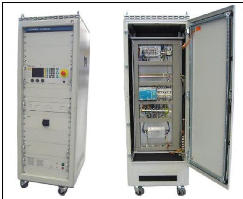
**Figura 3.16. Gabinete de control tipo T/D (16)**
