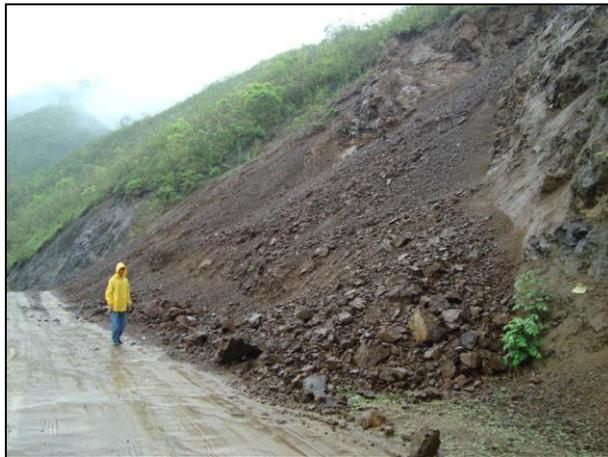
**Figura 3.6: Vista general del talud del camino a Coaque excavado en el aglomerado volcánico alterado.**
