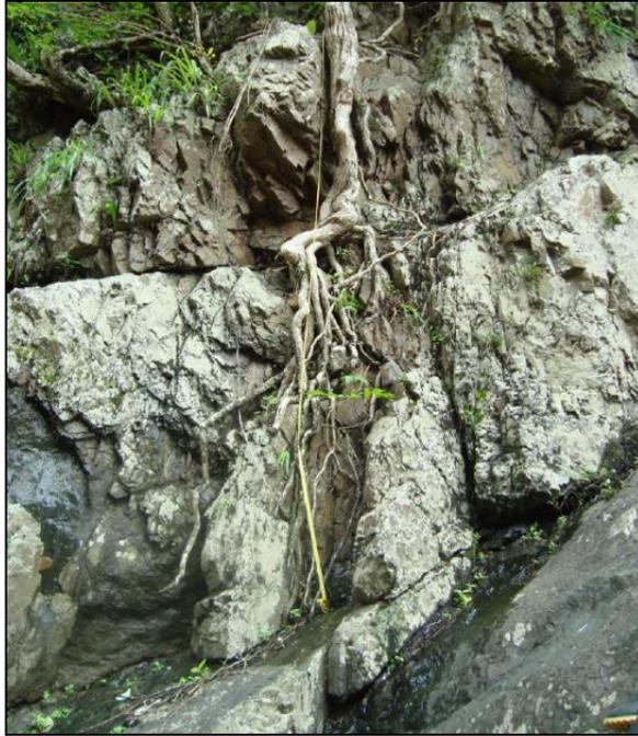
**Figura 3.33: Fracturas del macizo rocoso de la presa Jama.**
