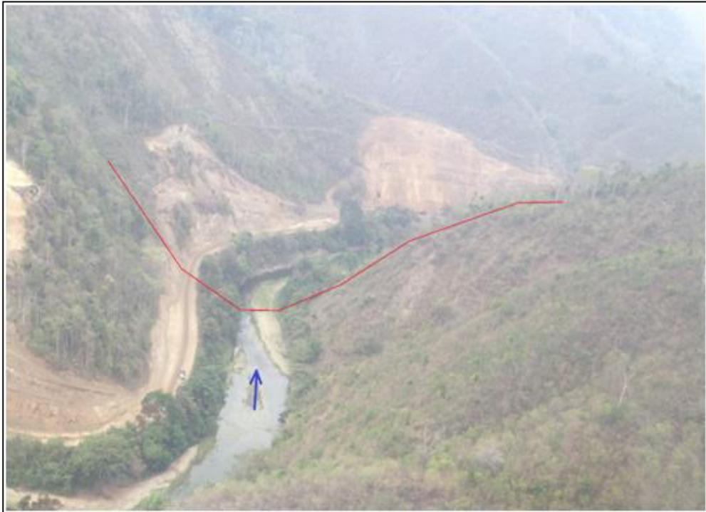
**Figura 3.3: Sitio de presa (Cerrada C1), vista del empotramiento derecho hacia abajo, nótese la existencia de una vía en construcción.**
