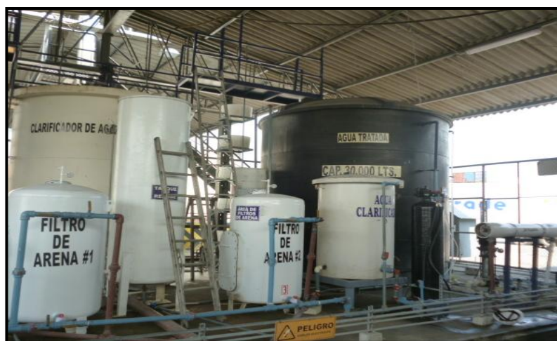
FIGURA 3.8 PLANTA DE TRATAMIENTO DE AGUAS RESIDUALES
