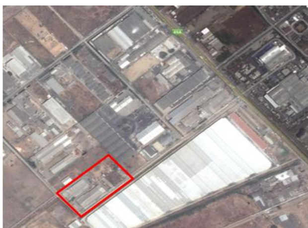
Figura 1.1 Vista satelital de la Ubicación de Galpón. [1]
