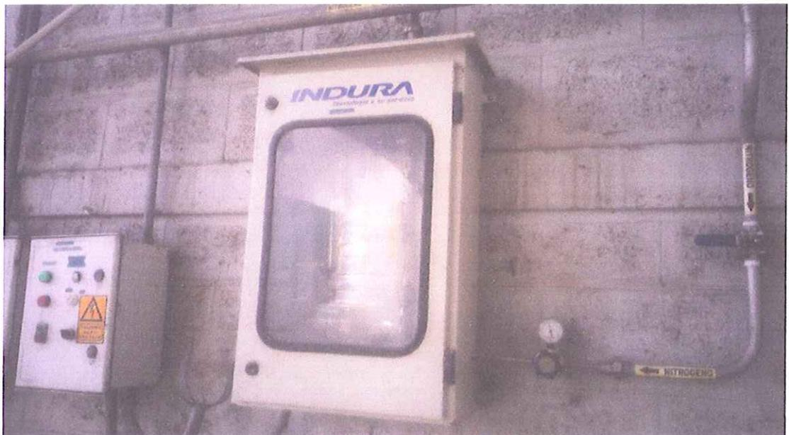
Figura 29.- Sistema de difusión - Tablero de control de flujo y presión
