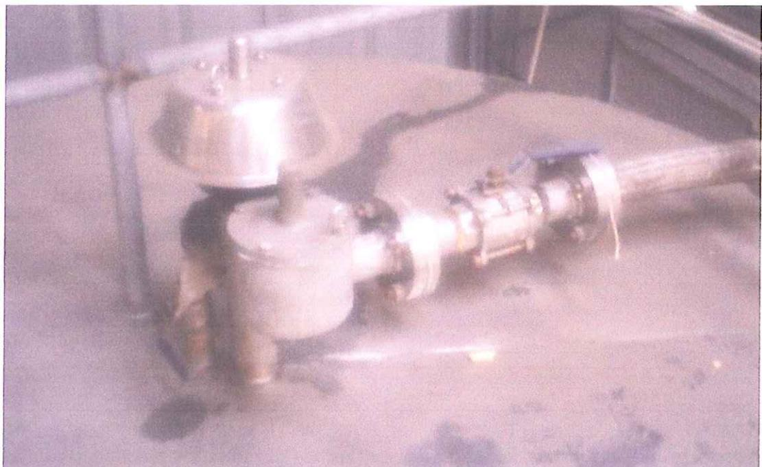
Figura 33.- Sistema de cobertura - Válvulas de alivio de presión
