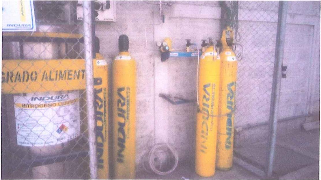
Figura 26.- Sistema de suministro central de nitrógeno
