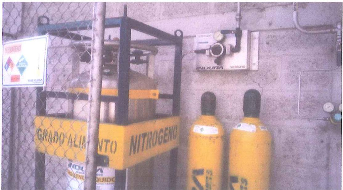
Figura 27.- Sistema de suministro central de nitrógeno
