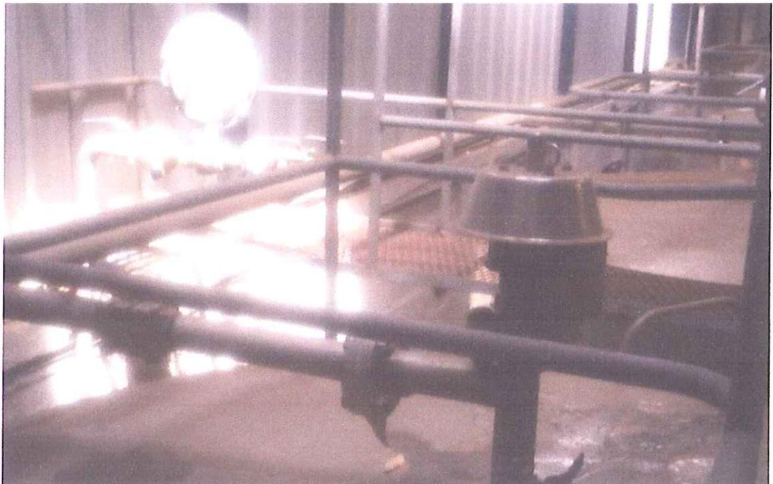
Figura 31.- Sistema de cobertura - Regulador de presión + válvulas de alivio de presión
