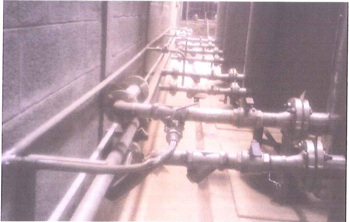
Figura 35.- Tuberías de carga y descarga de aceite
