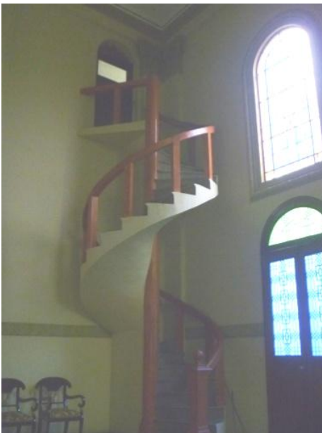
Foto No. 31: Escalera que conduce al campanario.
