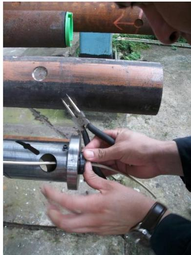
Figura 1.28 Colocación Del Centralizador
