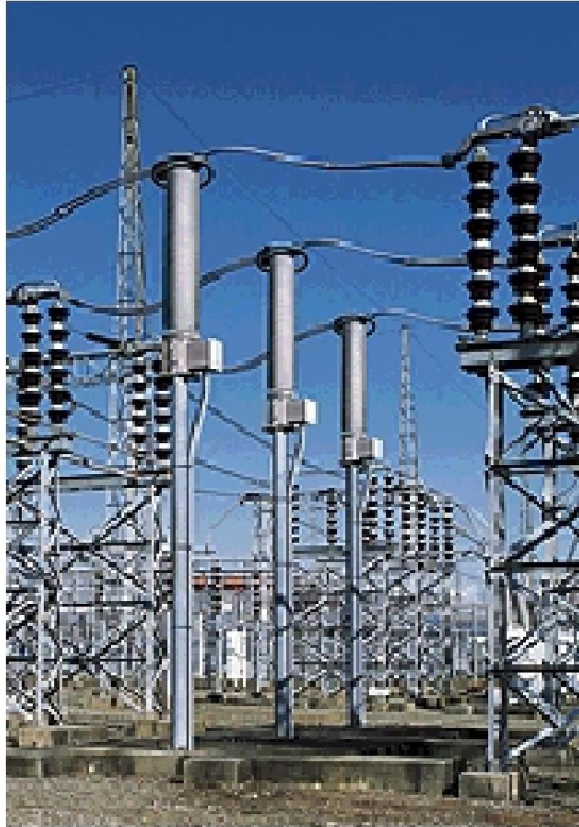
Figura 2.8 Transductor Optico de Voltaje y Corriente
