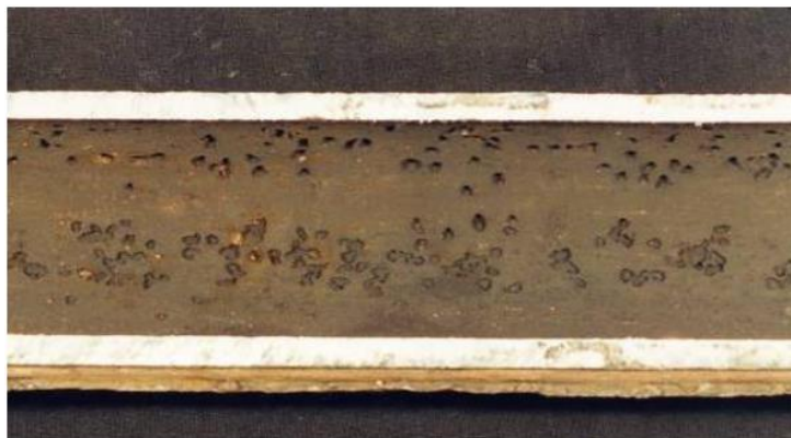
FIGURA 2.9 MECANISMO FALLA POR PICADURA.
