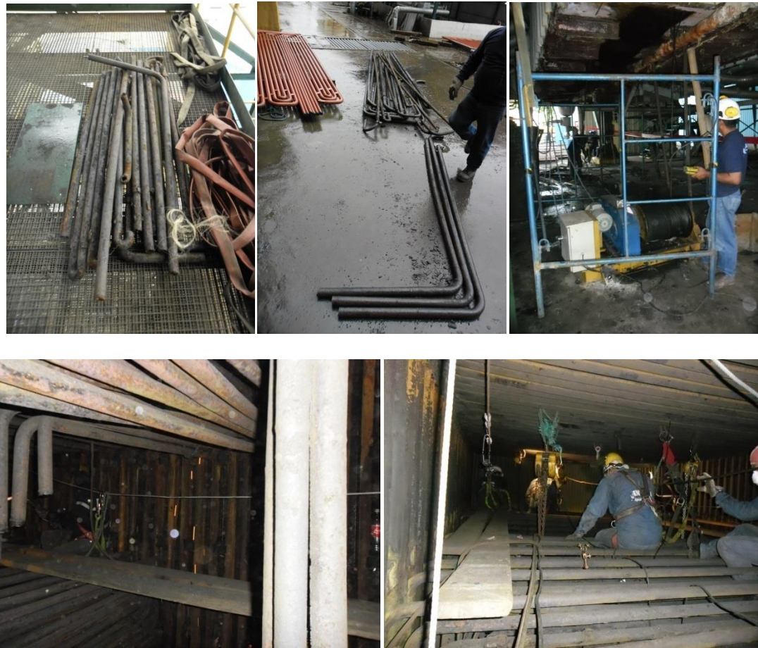
FIGURA 5.10 DESMONTAJE DE SECCIONES DE SOBRECALENTADOR.
