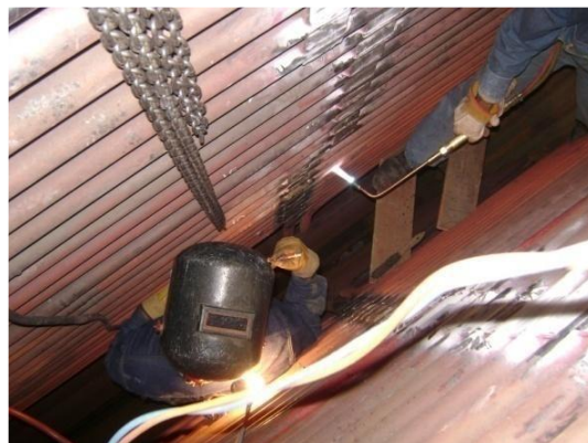
FIGURA 5.18. PRECALENTAMIENTO DE ELEMENTOS.
