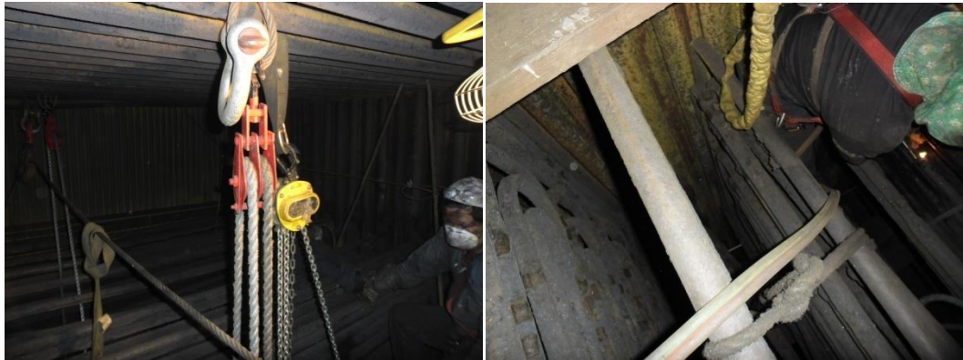
FIGURA 5.9 COLOCACIÓN DE FAJAS Y CUERDAS DE SEGURIDAD.
