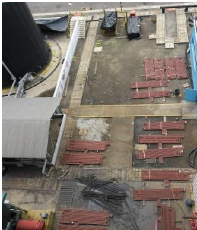
FIGURA 5.5 SEPARACIÓN Y MARCADO DE SECCIONES ANTES DEL MONTAJE.
