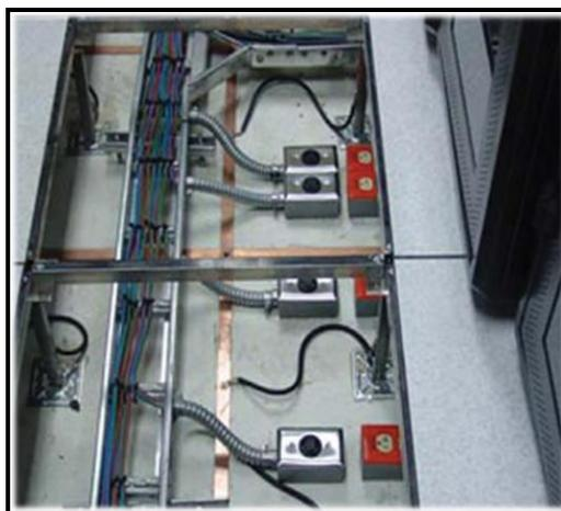
Figura 3.37 – Cableado Eléctrico bajo Piso Falso
