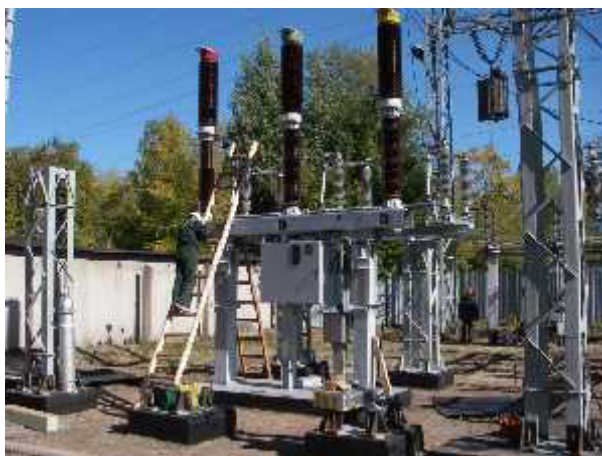
Gráfico 31 Interruptores de Potencia
