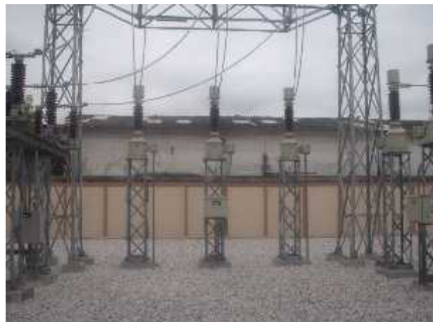
Gráfico 34 Transformadores de Potencial
