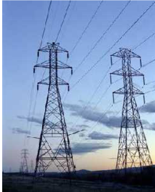
Gráfico 37 Línea de subtransmisión de 138kV.
