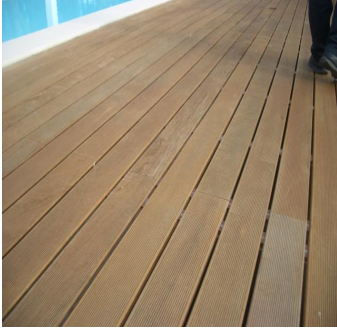
Foto No. 9: Guayacán Pechiche en Decking con anti slip.
