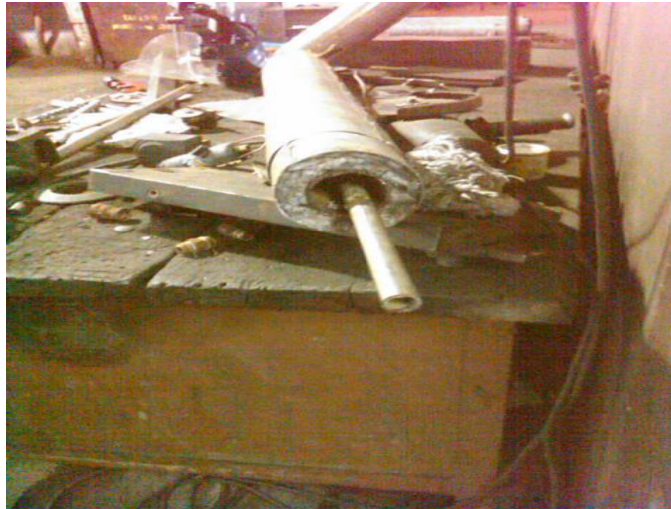
FIGURA 3.4 TAPONAMIENTO DE TUBOS DE ALIMENTACIÓN
