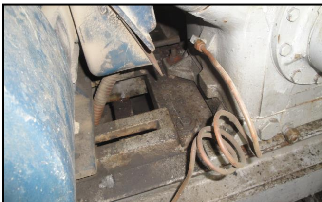
FIGURA 7.4 BASE DEL EQUIPO LLENA DE POLVO
