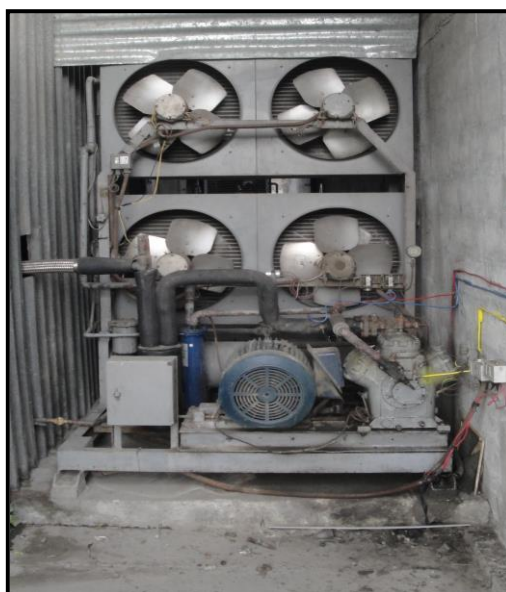
FIGURA 7.1 VISTA GENERAL DEL TÚNEL DE CONGELAMIENTO # 3.
