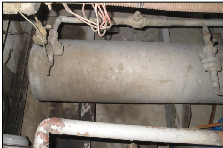
FIGURA 7.7 71 TANQUE RECIBIDOR.
