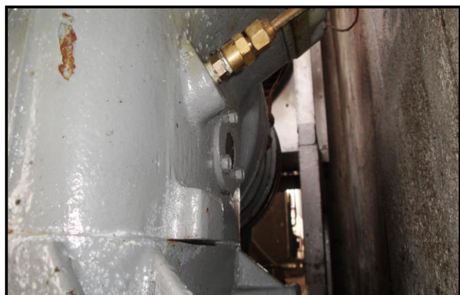
FIGURA 7.14 VISOR DE ACEITE LUGAR DE DIFÍCIL ACCESO
