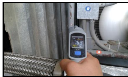
FIGURA 7.28 LECTURA DIFERENCIAL AL CONDENSADOR
