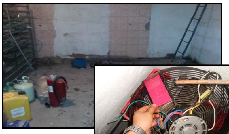
FIGURA 6.7 BODEGA DE REPUESTOS DURANTE ORGANIZACIÓN 3
