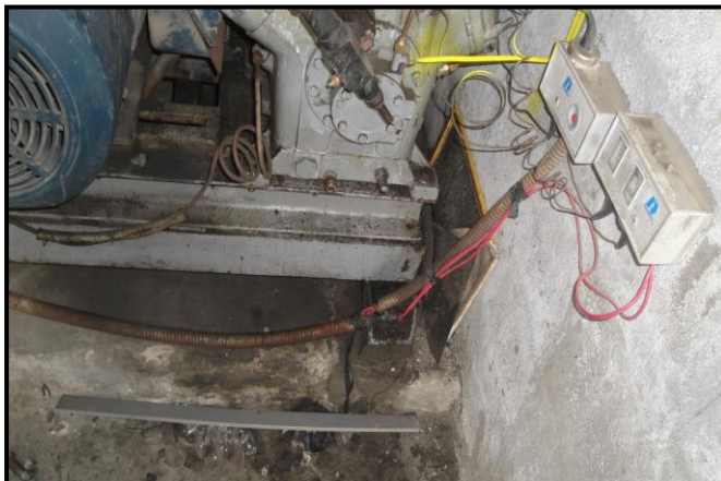
FIGURA 7.3 CONEXIONES DE LOS PRESOESTATOS.
