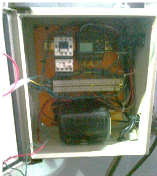
Figura 3.7.-Panel con controlador Logo, más susceptible hallarlo en el mercado y mucho más económico
