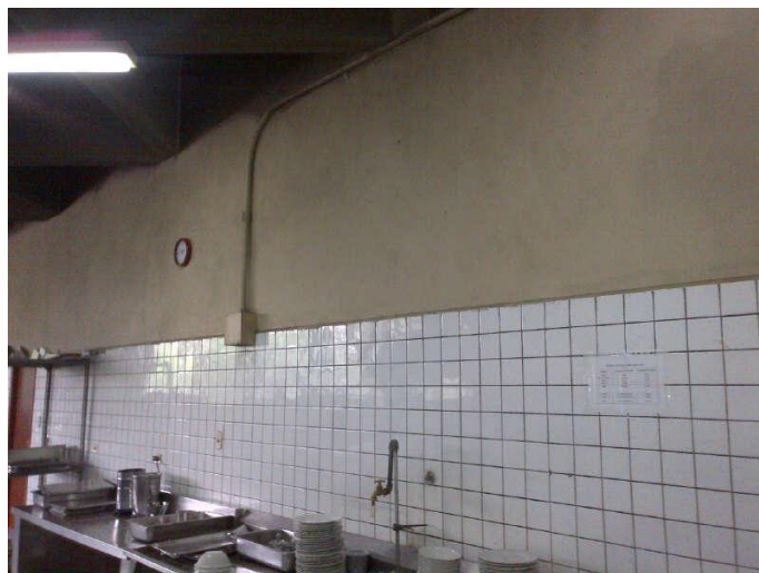
FIGURA 4.3 PAREDES EN ÁREA DE ELABORACIÓN
