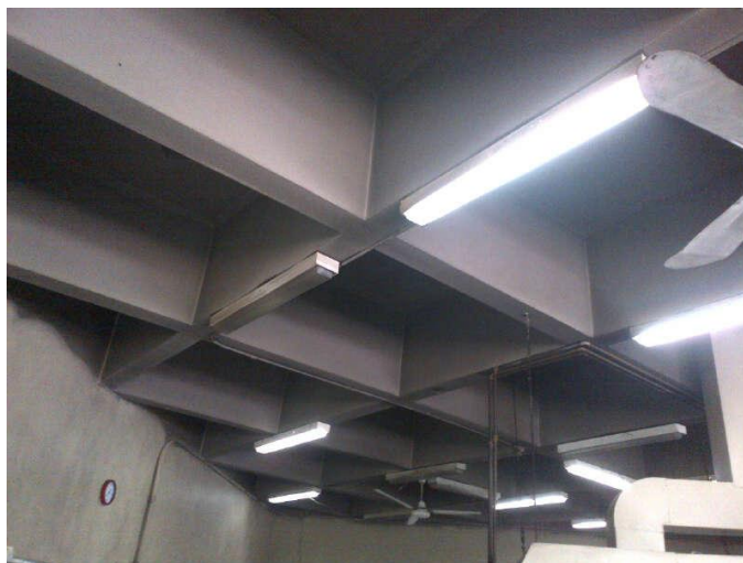
FIGURA 4.4 TECHO DEL COMEDOR ACTUAL
