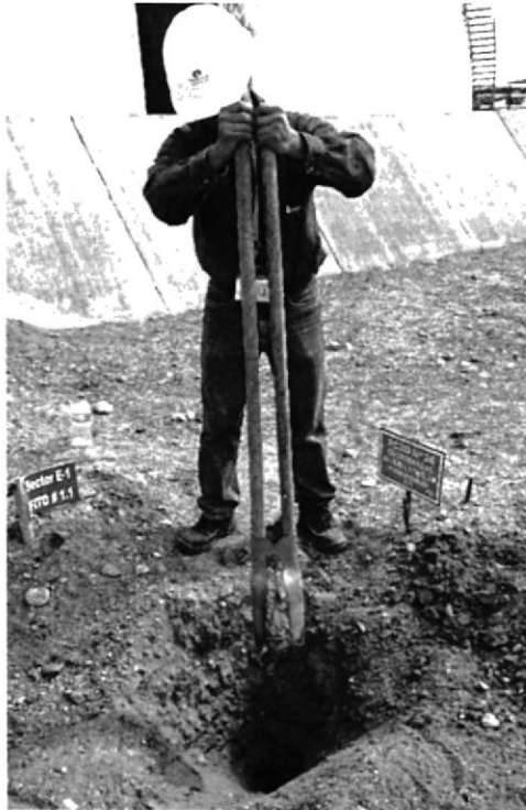
FOTO 2 (Perforación manual de calicata en zona de tanques de almacenamiento)
