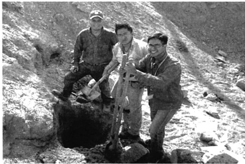
Figura 6.7: Excavación de calicatas en zona de playa
