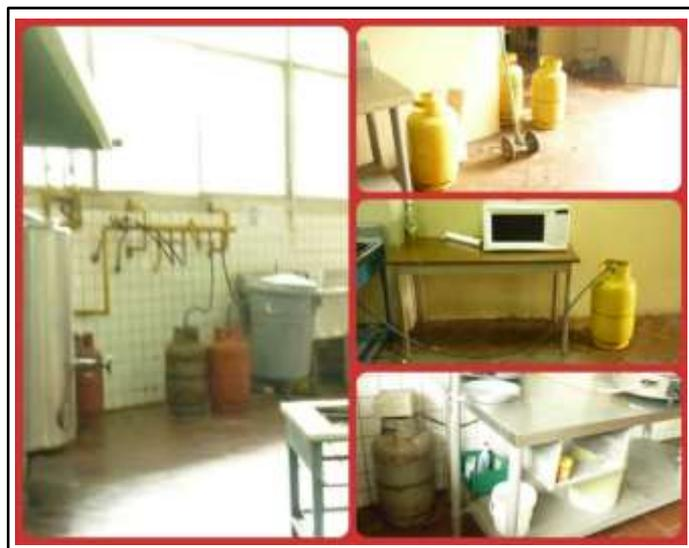
**Figura 4.7.** Ubicación de Tanque de GLP en el interior de la Cocina
