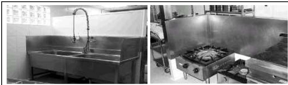
**Figura 5.3.** Protección de pared en fregaderos y equipos de cocción
