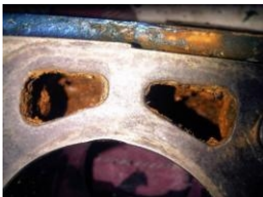
Conductos de refrigeración en bloque con sedimentos
