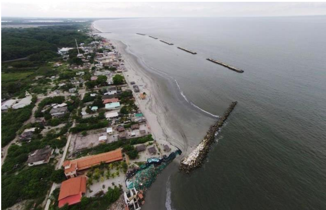
Ilustración 17. Escolleras y espigones de protección costera en Jambelí. Fuente: los autores (2015).
