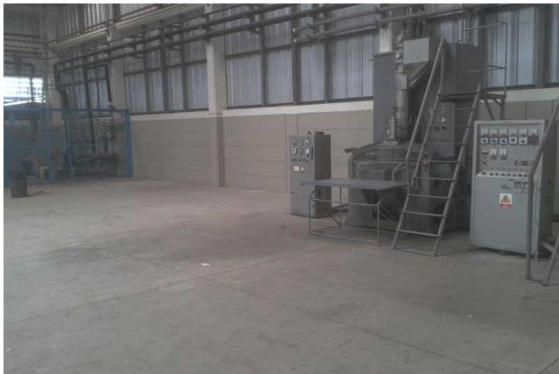
FIGURA 6.1 ANTES Y DESPUES ÁREA DE MP DE RUEDAS SOPLADAS PARA CAMIÓN
