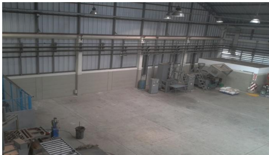
FIGURA 6.2 ANTES Y DESPUÉS ÁREA DE MÁQUINAS SOPLADORAS
