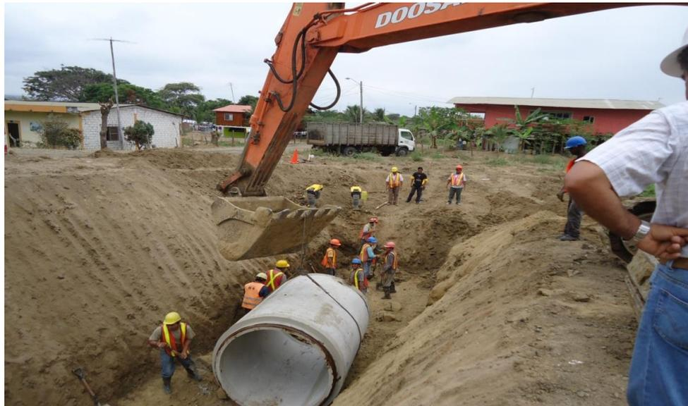
Figura 4.11 Colocación de una tubería.
