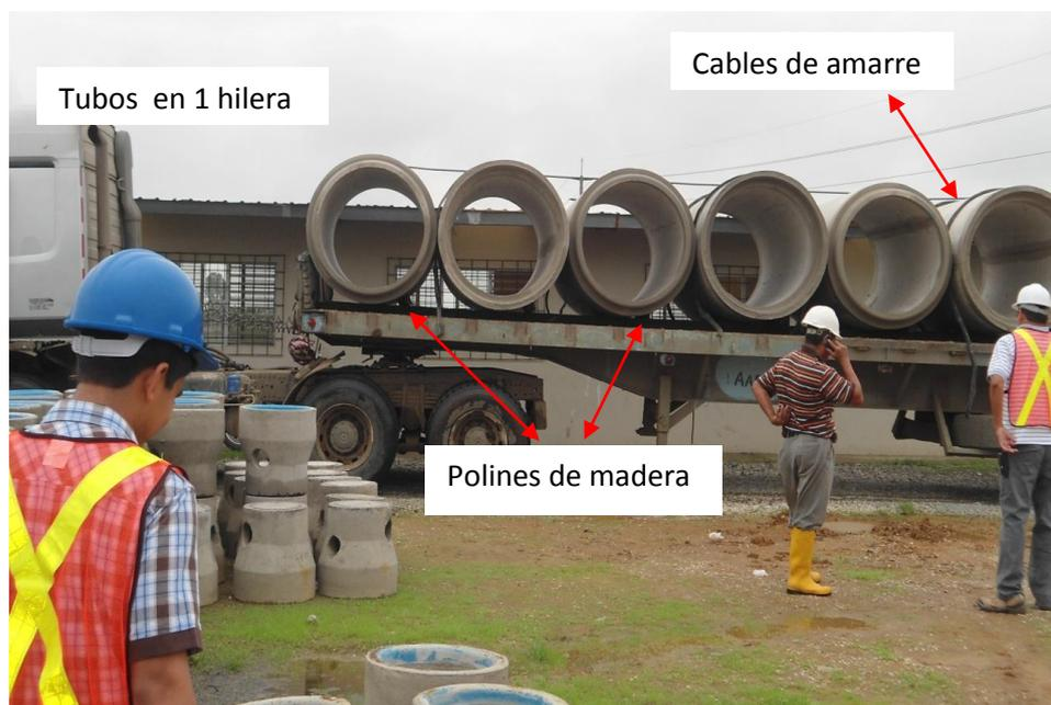
Figura 1.10 Transporte de tubos de hormigón armado
