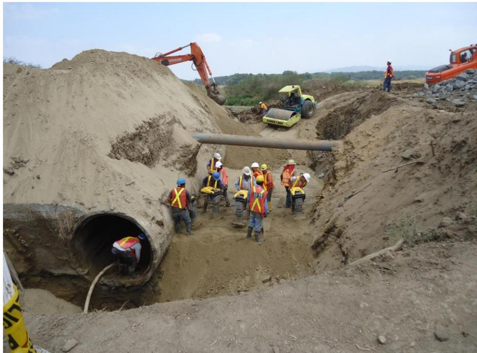
Figura 5.3 Limpieza manual de la alcantarilla.
