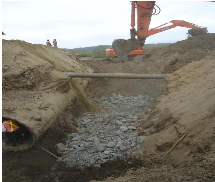
Figura 4.9 Colocación del replantillo de base clase 1B
