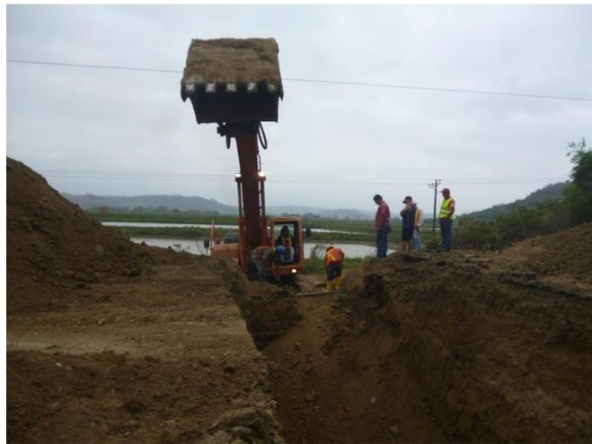
Figura 4.2 Excavación en el eje de la alcantarilla.
