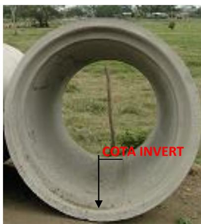
Figura 2.12 Cota invert de la tubería
