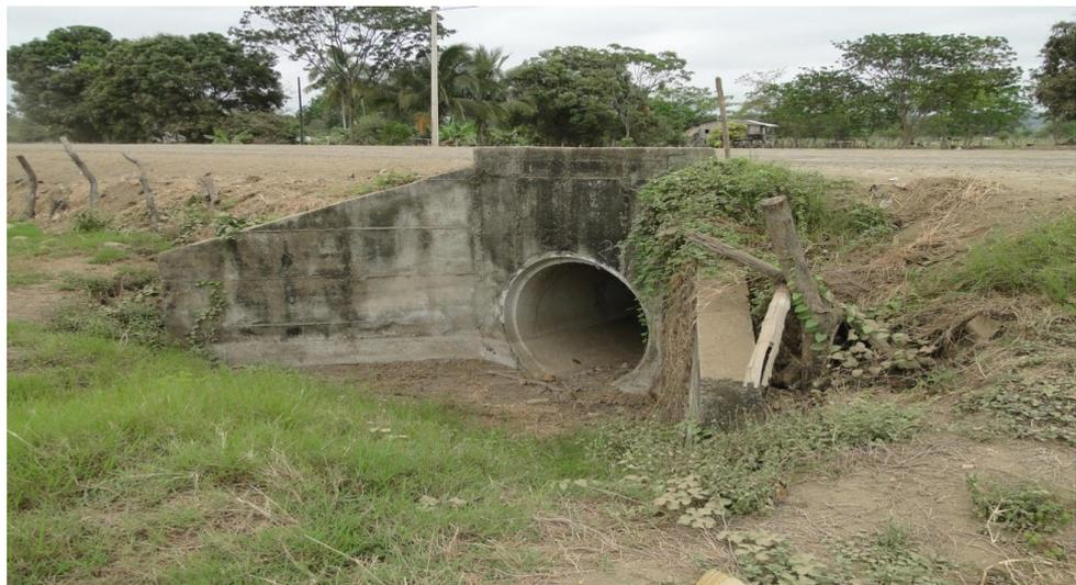
Figura 5.4 Estado inicial de muro de alas
