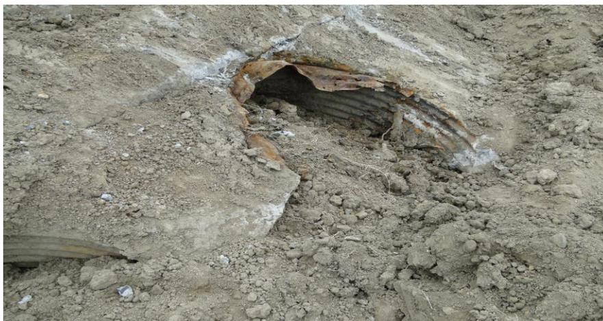
Figura 2.3 Alcantarillas existentes en mal estado
