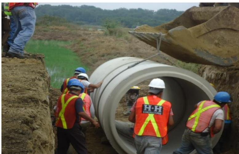
Figura 4.14 Unión de las tuberías
