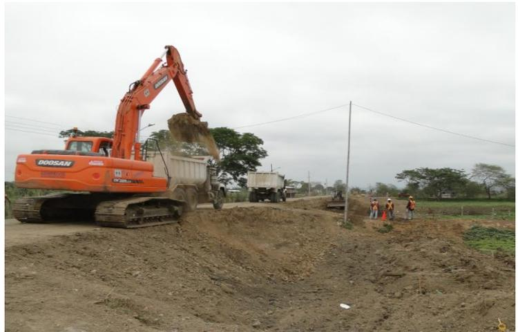
Figura 4.1 Maquinaria realizando desalojo de manera continua
