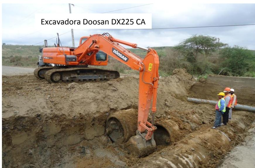
Figura 2.16 Maquinaria utilizada para instalación de las tuberías
