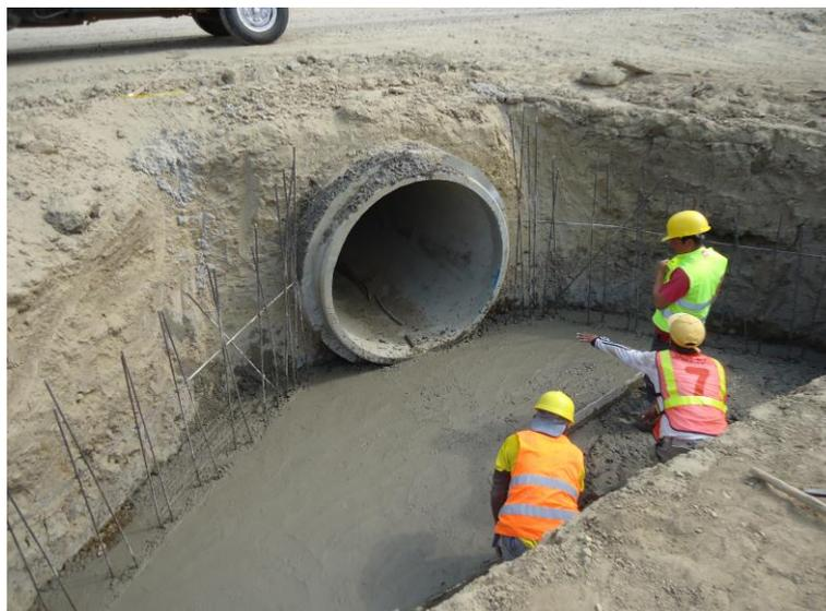
Figura 2.14 Fundición de losa de hormigón armado.
