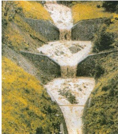
Foto 17 Canal con sistema de retención del agua sedimentos y reducción de la energía.
