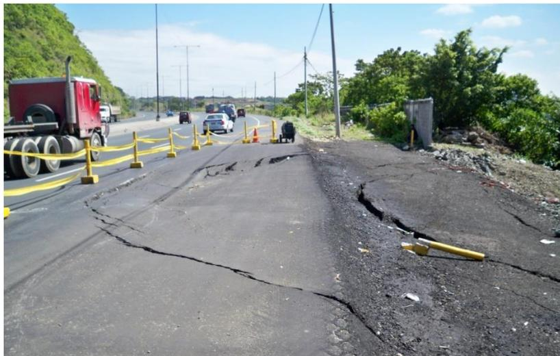
Foto 8 Deslizamiento al pie de la vía Perimetral que está construida sobre el depósito aluvial.
