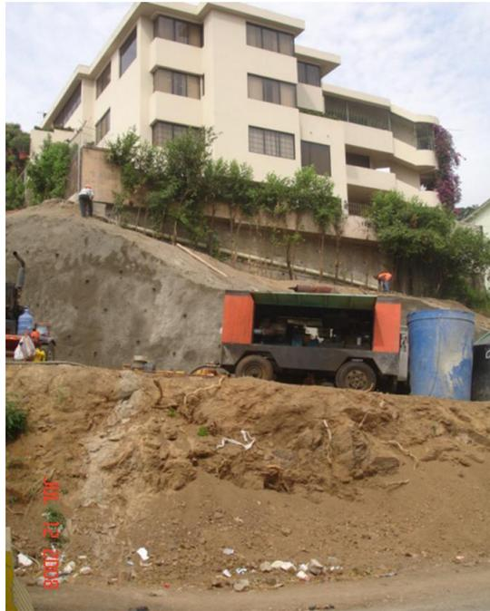
Foto 15 Corte de un talud de 80° y estabilización mediante bulones anclados, malla electro soldada, drenes filtro y una capa de hormigón proyectado.
