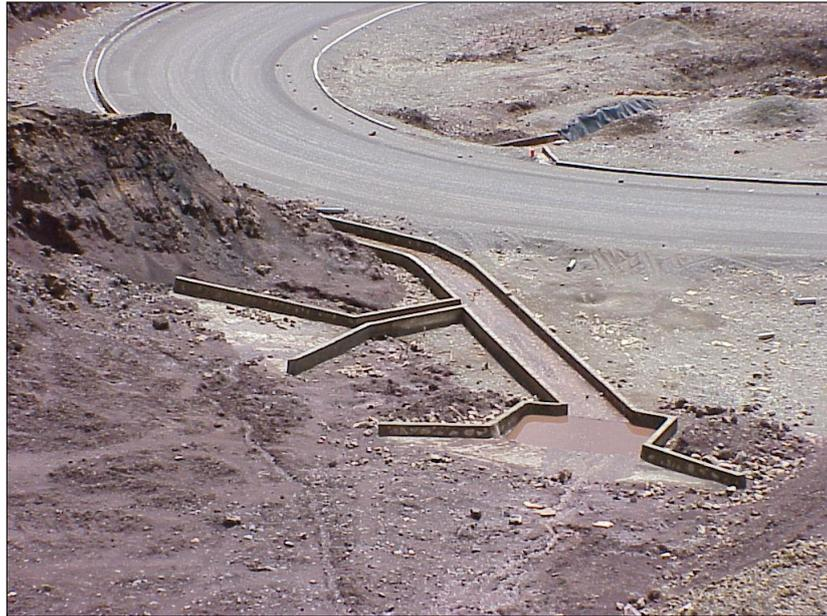
Foto 13 Control de la erosión de materiales finos sobre una calzada.
