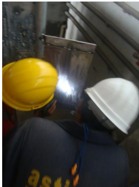
Figura 2. 14.- Inspección visual realizada junto al inspector de la empresa calificadora
