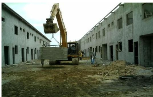
**FIGURA 3.6.- CISTERNAS PREFABRICADAS**
