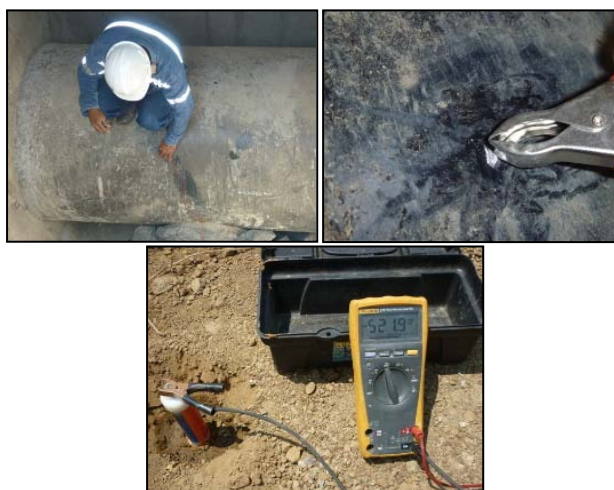
FIG. 3.5. MEDICIÓN DE POTENCIALES ELÉCTRICOS
