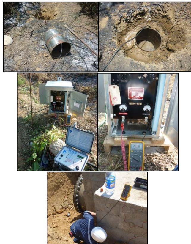
FIG. 3.2. PRUEBA DE CONDUCTANCIA ELÉCTRICA DEL RECUBRIMIENTO
