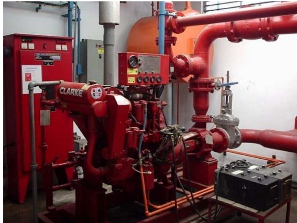
FIGURA 4.1 PANELES DE CONTROL PARA LAS BOMBAS
