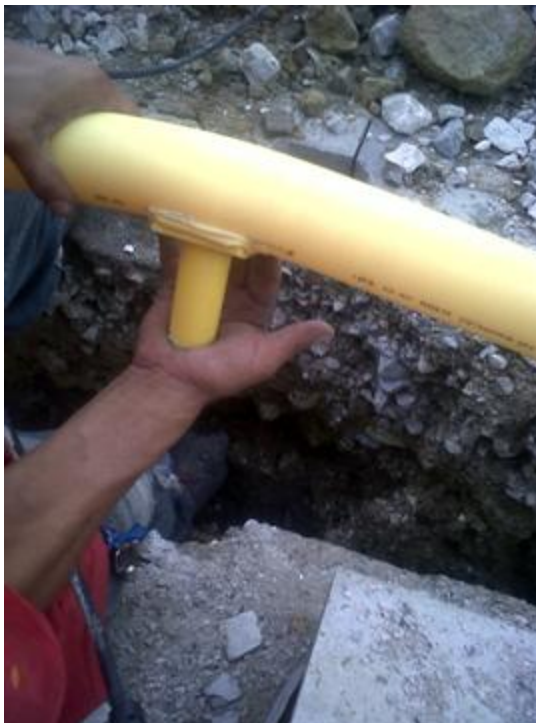
FIGURA 12 :INSTALACIÓN DE LA SILLETA EN LA TUBERÍA
