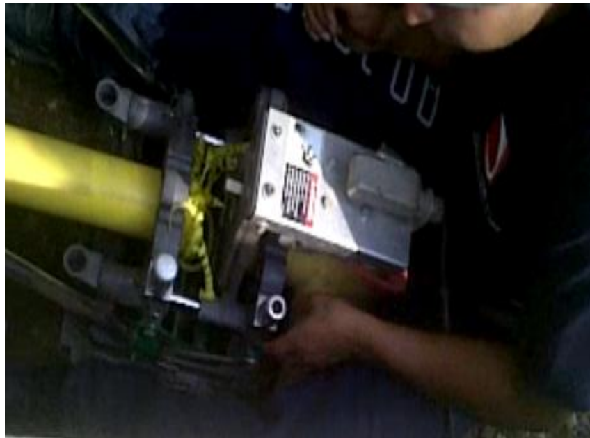
FIGURA 15 : REFRENTADO DE LA TUBERÍA DE POLIETILENO
