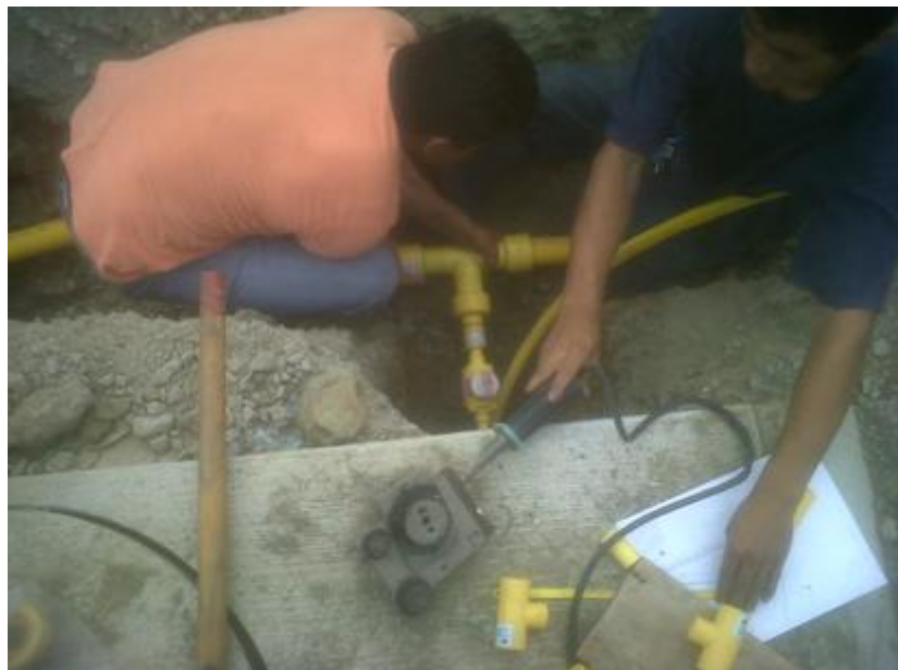
FIGURA 20: UNIÓN DE LAS PIEZAS POR TERMOFUSIÓN CON MANGUITOS
