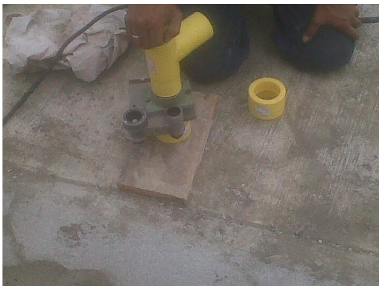
FIGURA 19: CALENTAMIENTO DE ACCESORIOS CON SOCKET
