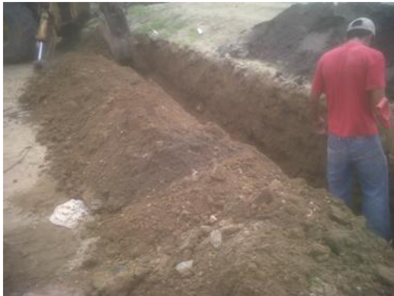
FIGURA 6:EXCAVACIÓN DE LA ZANJA
