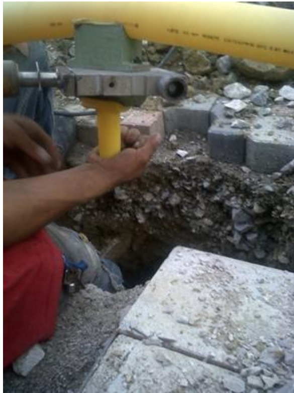
FIGURA 11: CALENTAMIENTO DE LA SILLETA Y LA TUBERÍA
