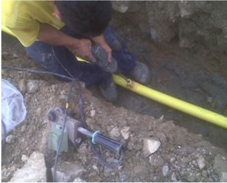
FIGURA 13: PERFORACIÓN DE ORIFICIO PARA ACOMETIDA
