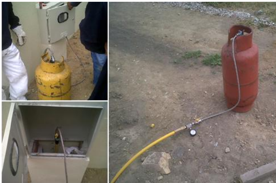
FIGURA 27: PRUEBA DE PRESIÓN REALIZADA POR LA INSTALADORA
