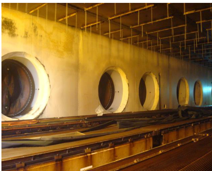
FIGURA 2.11 LAS 6 VÁLVULAS TIPO MARIPOSA QUE CONECTAN LA CÁMARA DE VACÍO CON LOS CONDENSADORES
