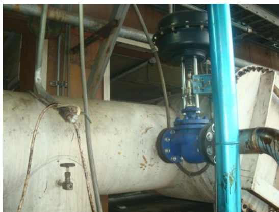
FIGURA 2.6 VÁLVULA DE CONTROL PROPORCIONAL QUE INYECTA VAPOR A LA TUBERÍA DE VACÍO
