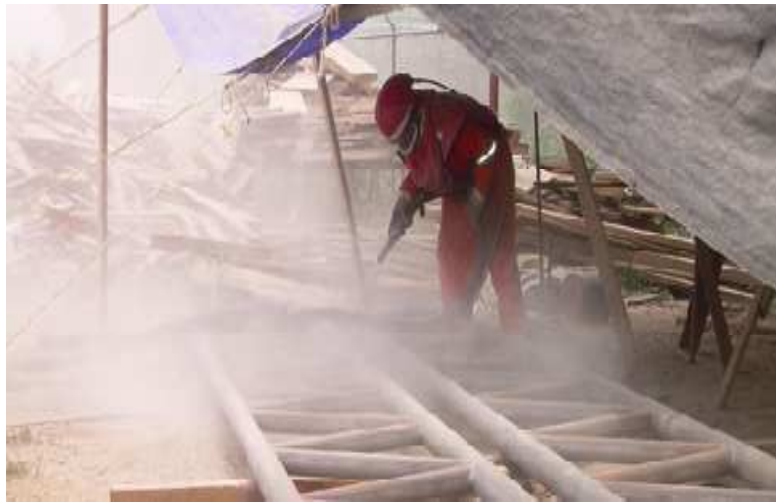
Figura 1.1 APLICACIÓN DE SANDBLASTING.
