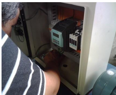
FIG. 2.25 FOTOGRAFÍA DEL MONTAJE DEL TABLERO DE CONTROL
