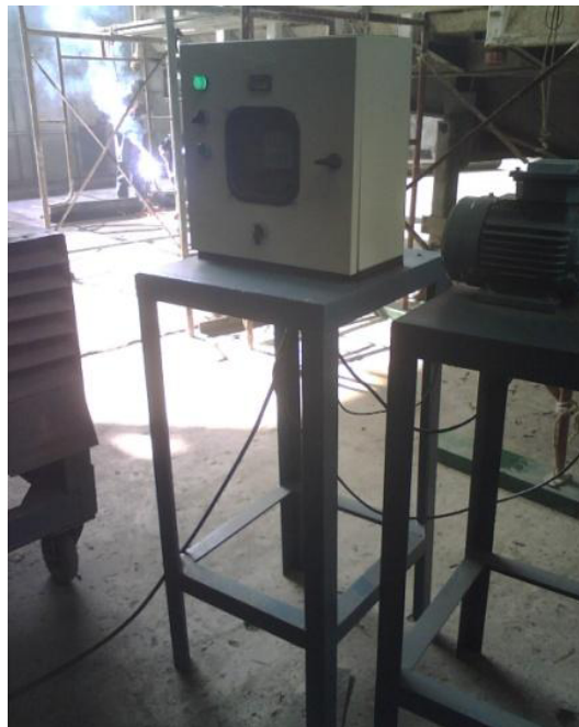
FIG. 2.20 FOTOGRAFÍA DE LA ESTRUCTURA DE SOPORTE TERMINADA
