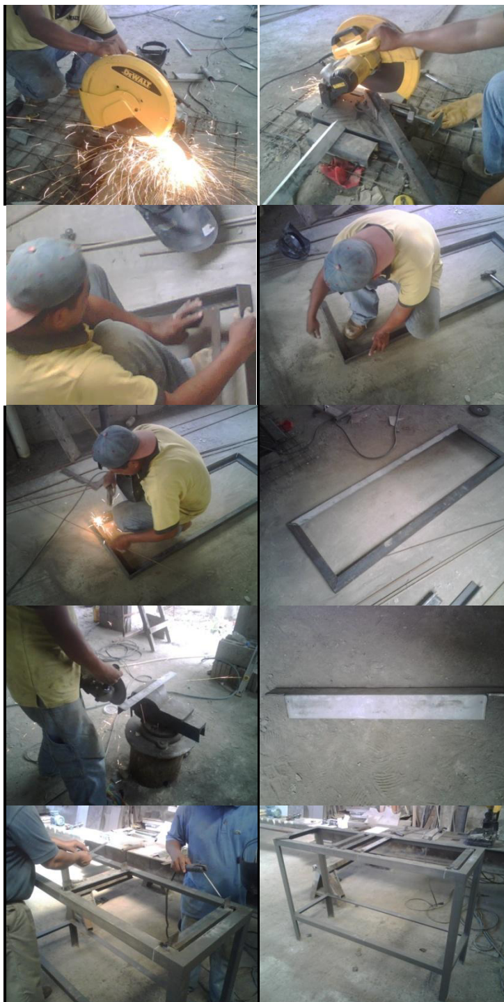
FIG. 2.10 PROCESO DE CONSTRUCCIÓN DE LA ESTRUCTURA METÁLICA
