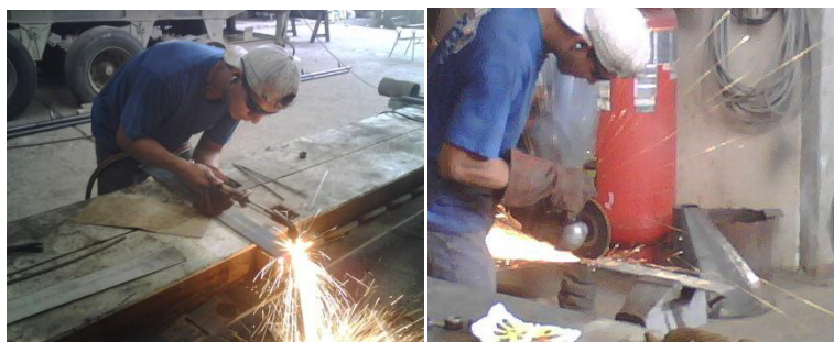
FIG. 2.17 PROCESO DE CONSTRUCCIÓN DE PLATINA DE SOPORTE
