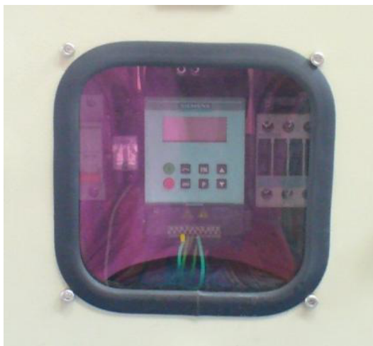
FIG. 2.23 FOTOGRAFÍA DE LA MIRILLA DE INSPECCIÓN TERMINADA
