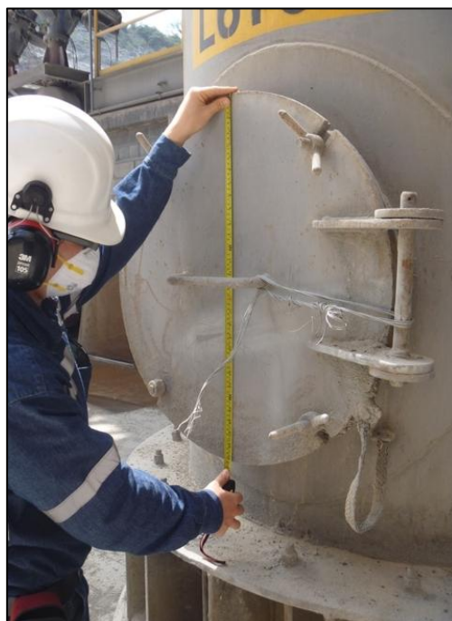
FIGURA 2.2. TOMA DE DIMENSIÓN DEL MANHOLE
