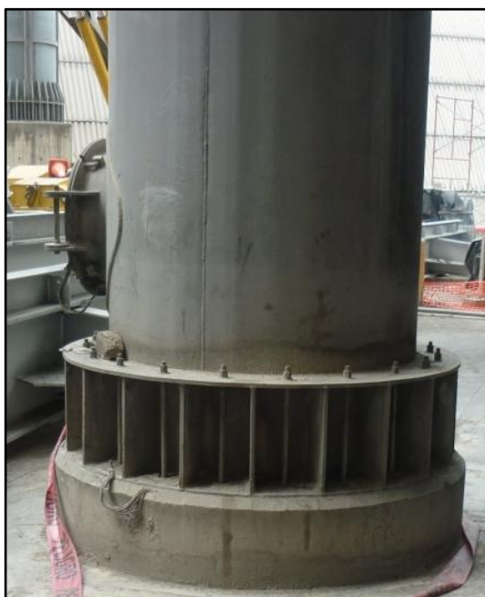
FIGURA 3.3. ANCLAJE DE LA CHIMENEA AL SUELO (CIMENTACIÓN)
