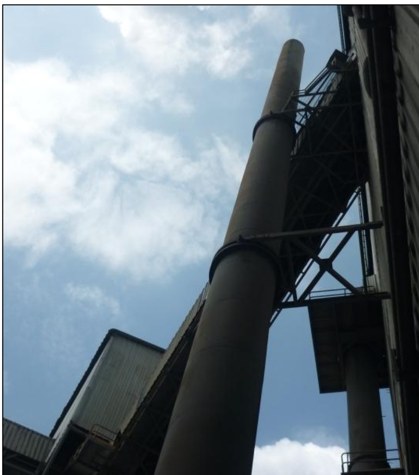
FIGURA 2.1. VISTA PANORÁMICA DE LA CHIMENEA
