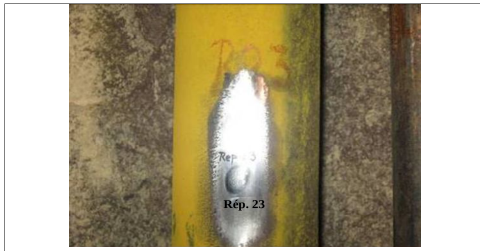
Fig. 80 Ubicación en cota 3 mts. Tubo 6 Paso 2.
