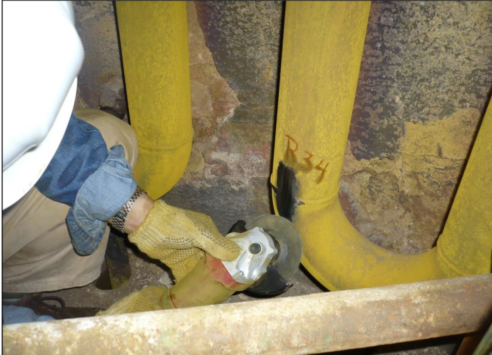
Figura 2.3 DESBASTE GRUESO CON LA AMOLADORA
