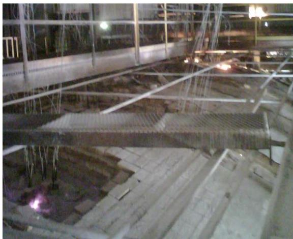
Fig. 3.1 Estado de la Corona del Horno Regenerativo
