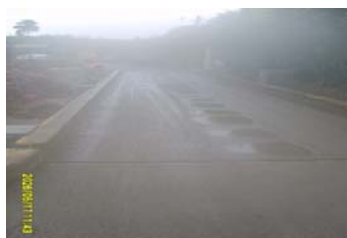
FIGURA 4.1 BÁSCULA CAMIONERA CON CAPACIDAD MÁXIMA DE 80 TONELADAS
