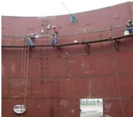
Figura 4.36 Soldadura del cuerpo.
