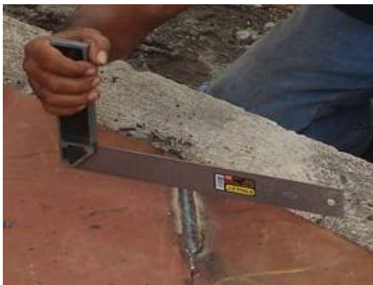
Figura 4.29 Soldadura en el fondo
