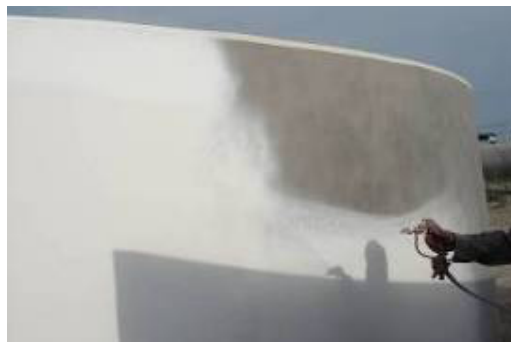
Figura 4.23 Primera capa de protección superficial
