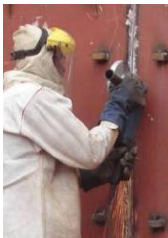
Figura 4.35(b) Limpieza soldadura vertical del cuerpo
