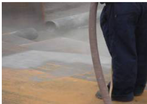
Figura 4.22 Chorro abrasivo con arena (FONDO)
