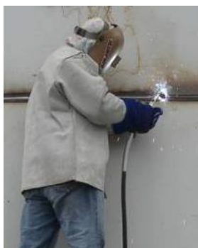
Figura 4.35(a) Soldadura circunferencial del cuerpo
