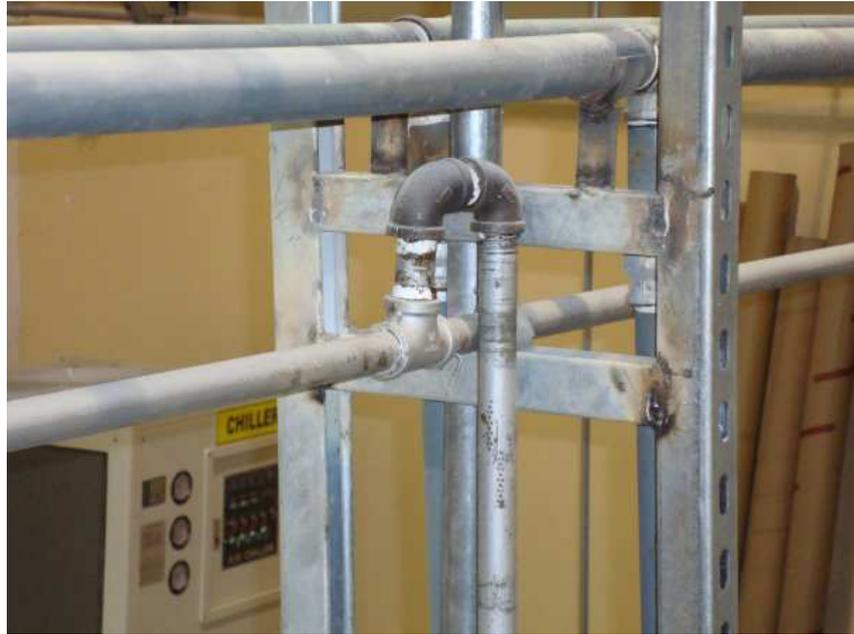
**FIGURA 3.3 CUELLO DE CISNE DE SISTEMA DE AIRE COMPRIMIDO.**
