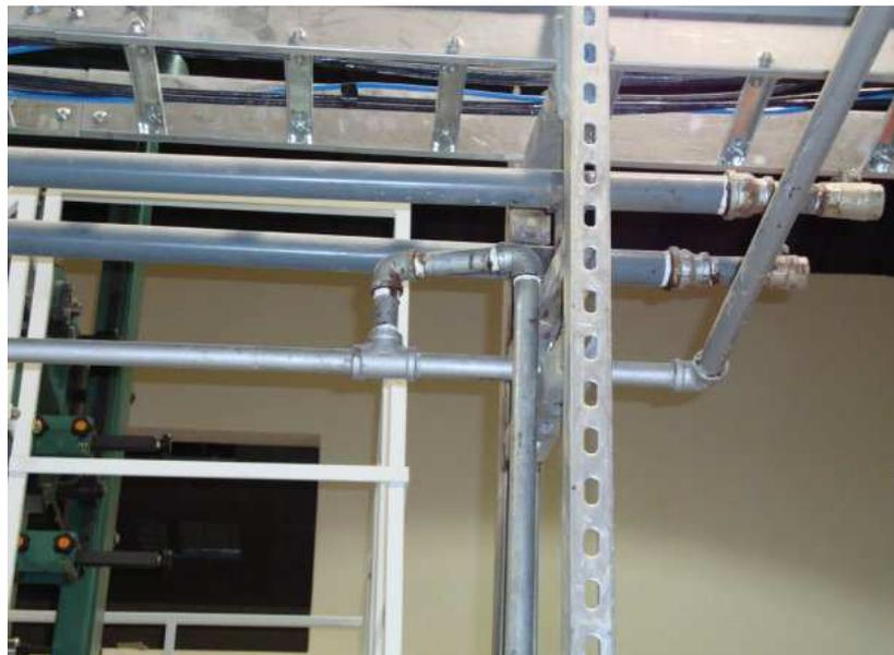
**FIGURA 3.2 TUBERÍA DE SISTEMA DE ENFRIAMIENTO DE AGUA**
