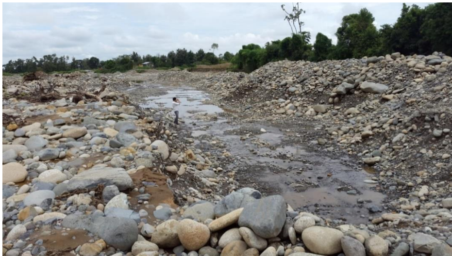
Figura 14. Profundidad de excavación
