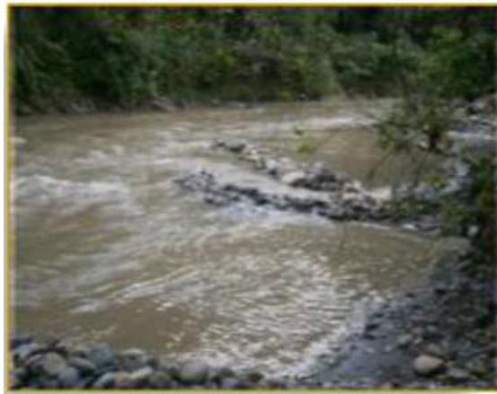
Figura 4. Trampa de grava
