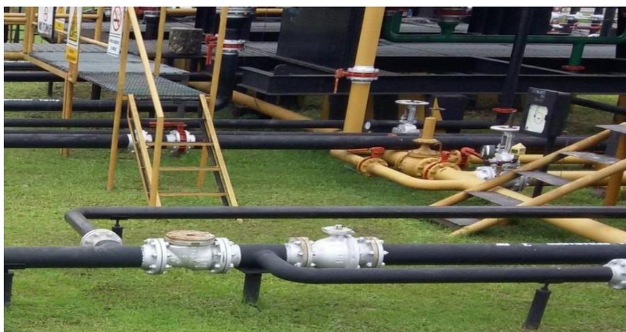
Figura 4.3 Válvulas reguladoras de control de flujo
