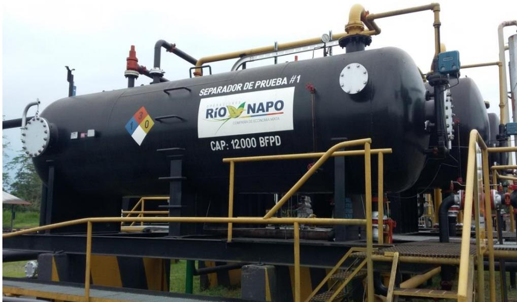
Figura 4.2 Separador de prueba
