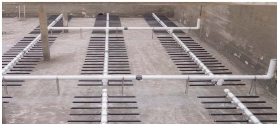
**FIGURA 3.35. Diseño de un sistema de inyección de aire por medio de tuberías para el tratamiento de aguas residuales.**
