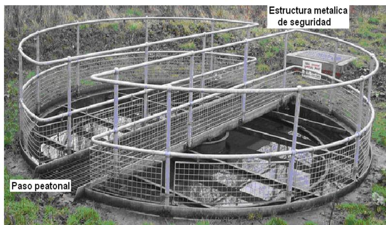
**FIGURA 3.38. Diseño de un tanque para el tamizado.**
