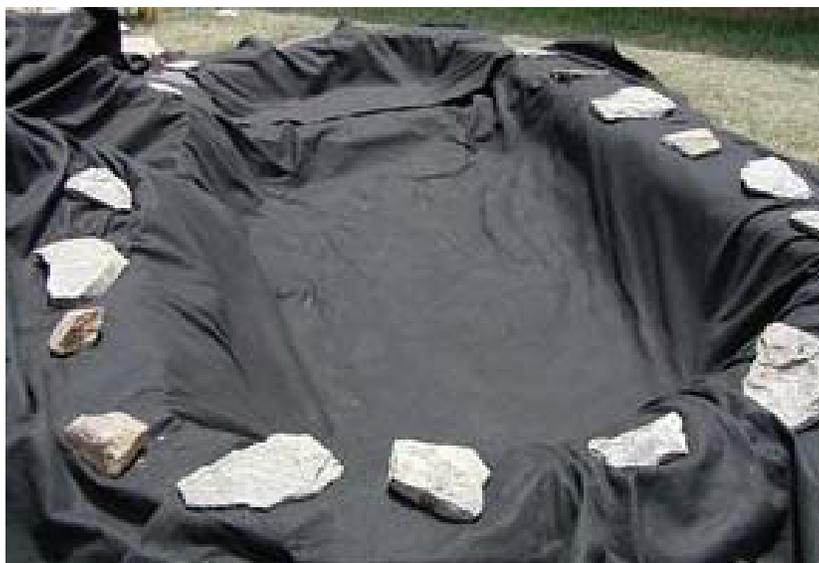
**FIGURA 3.36. Tolda para cubrir la superficie de las piscinas de oxigenación.**
