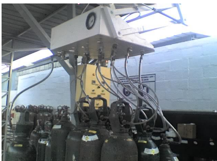
FIGURA 3.10. CONEXIÓN DE CILINDROS CON EL RAK
