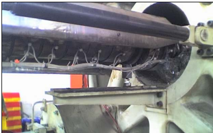
FIGURA 3.13. TUNEL DE CALEFACCIÓN
