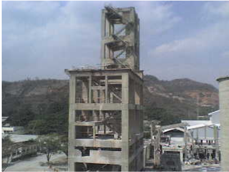
FIGURA 2.2. ESTRUCTURA DE CONCRETO PARA LOS HORNOS, MOLINOS Y CICLONES EN LA TORRE 1 DE LA PLANTA CLINCAL ("SAN EDUARDO" HOLCIM-ECUADOR).
