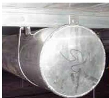
**FIGURA 3.13 SILLAS DE FLOTADOR**
