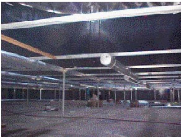
**FIGURA 3.8 INSTALACION DE MEMBRANA FLOTANTE**
