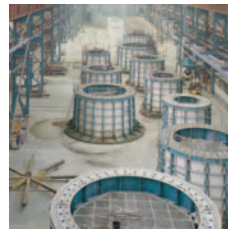
Producción de torres de hormigón prefabricadas ENERCON
