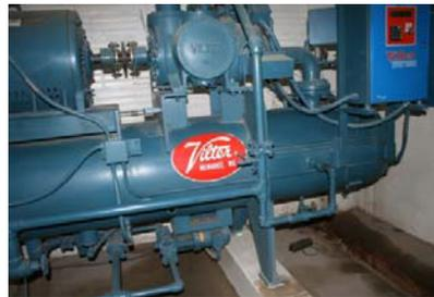
**FIGURA 3.11 COMPRESORES DE TORNILLO**
