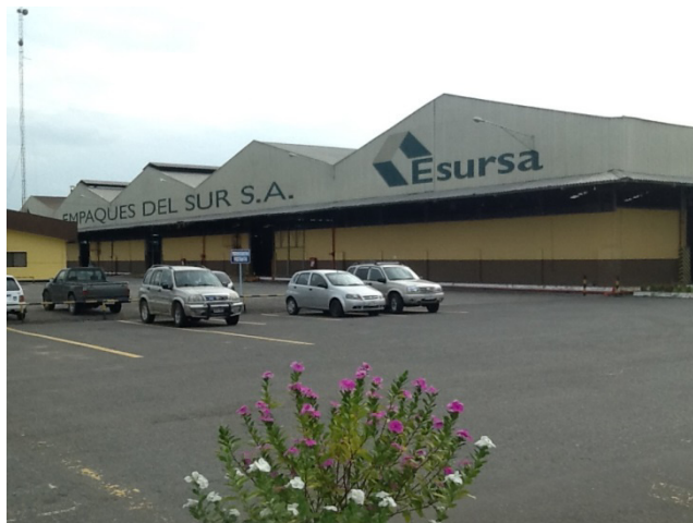
Vista frontal de Empresa Empaques del Sur S.A (ESURSA)
